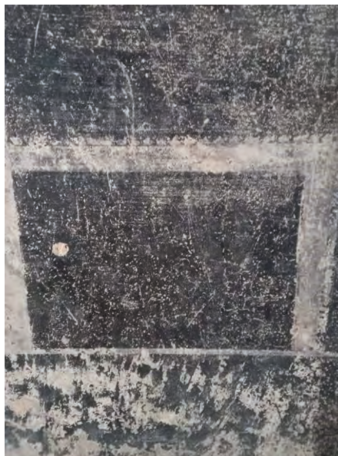
После проведения работ
