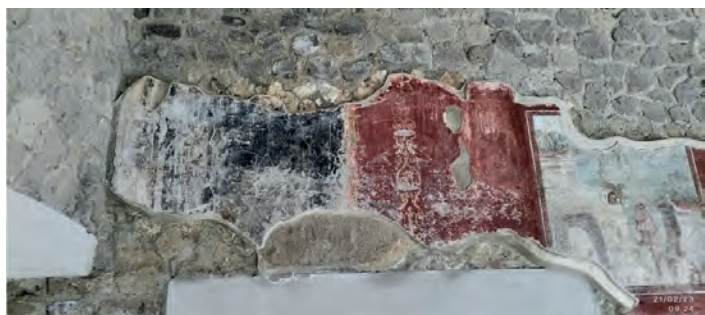
До проведения работ
