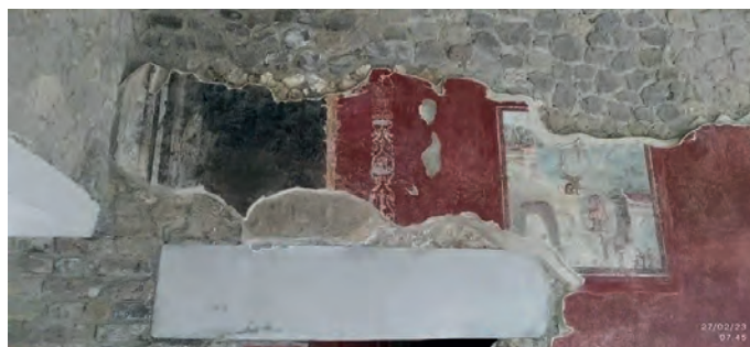
После проведения работ
