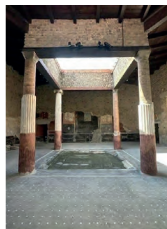
После проведения работ
