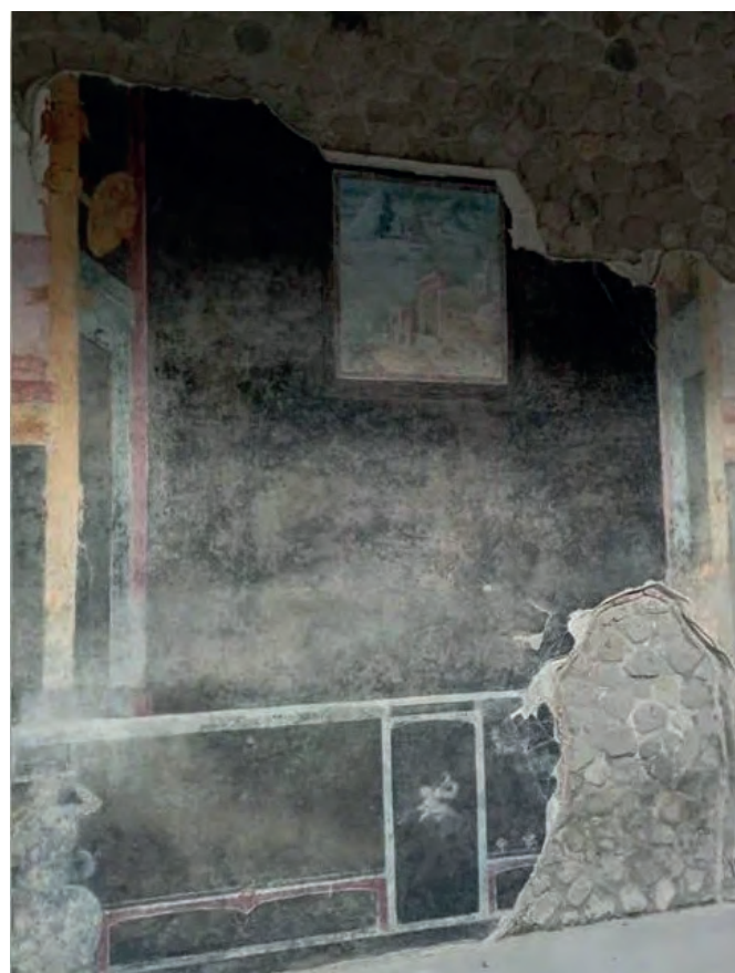
После проведения работ
