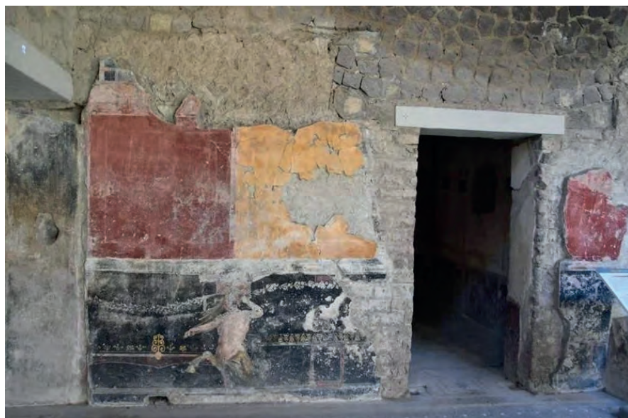
До проведения работ
