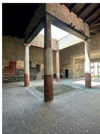
После проведения работ
