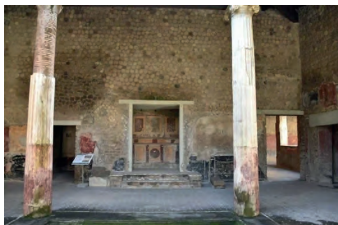
До проведения работ
