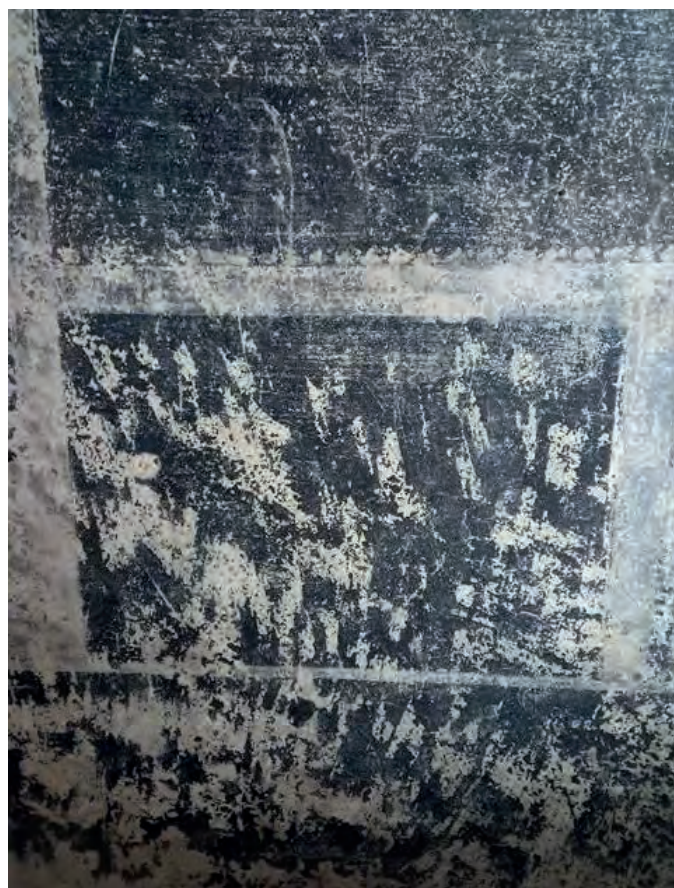
До проведения работ
