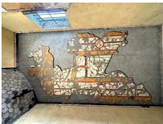
До проведения работ
