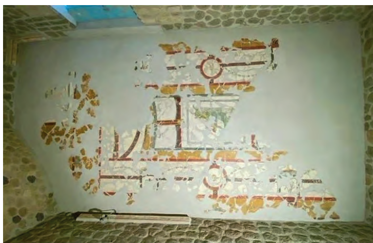
После проведения работ
