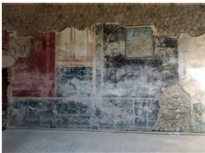
До проведения работ
