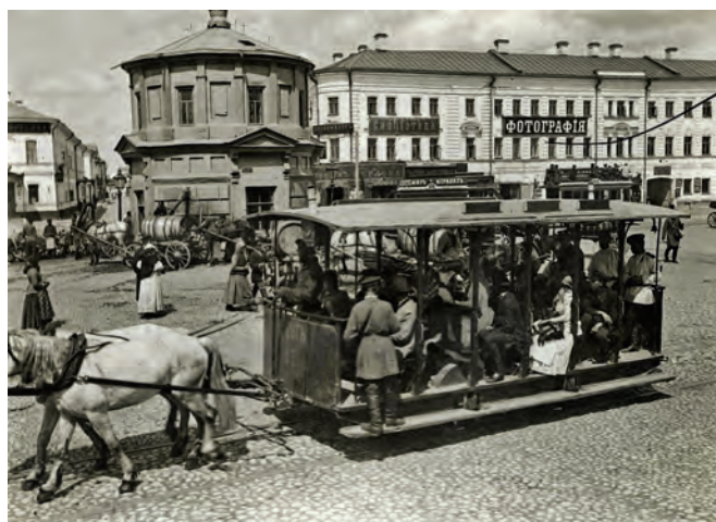
Рис. 7. Конка на Серпуховской площади. На заднем плане начало улицы Большая Ордынка и водонапорная башня. Фото конца XIX в.
