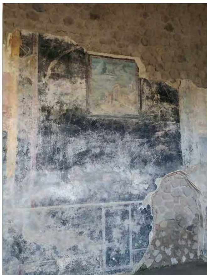
До проведения работ
