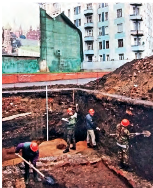
Рис. 3. Никитский бульвар, вл. 6/20. Раскоп № 1. Рабочий момент. Фото.
