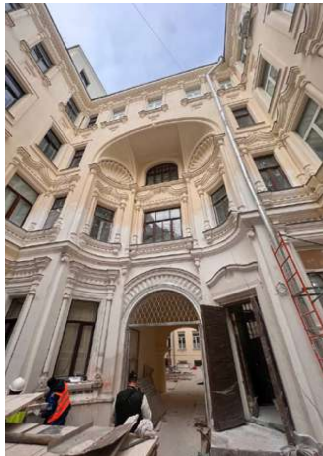
Изобр. 16. Реставрационные работы по лепному декору на фасадах
