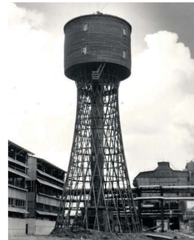
Изобр. 4. Водонапорная башня на территории Выксунского металлургического завода. Фото А. В. Косицына, 1976 г. Архив УГО ОКН Нижегородской области
