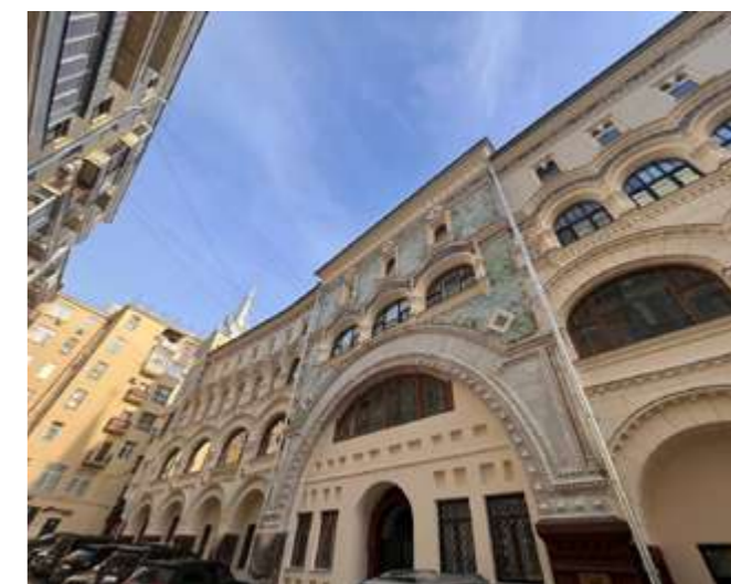
Изобр. 15. Реставрационные работы по лепному декору на фасадах
