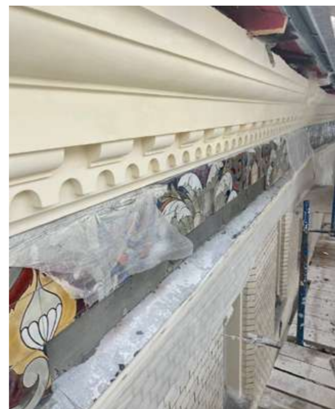
Изобр. 13. Работа по восстановлению утраченной керамической части фриза под венчающим карнизом
