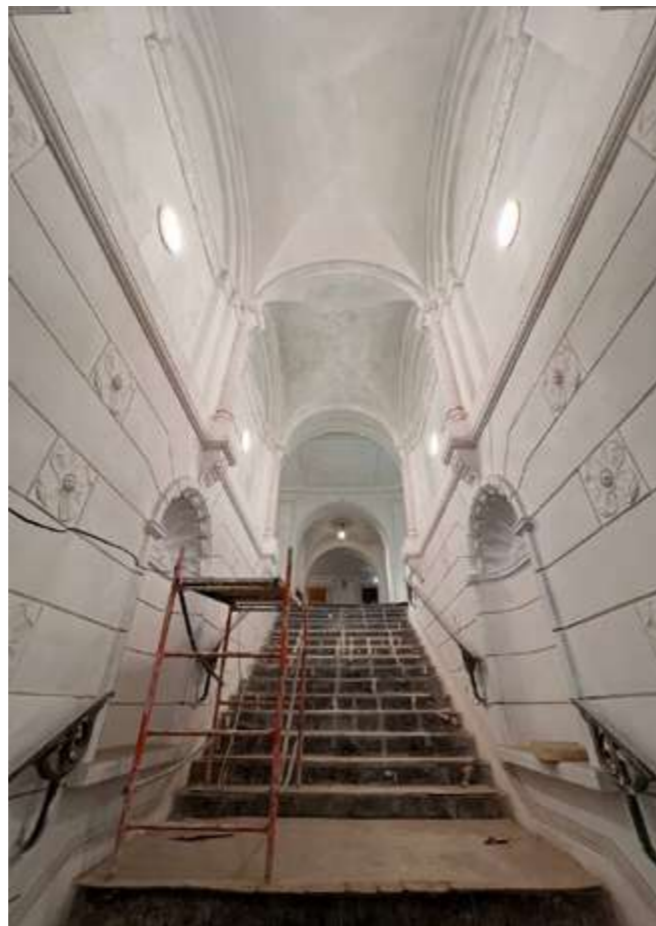
Изобр. 17. Реставрационные работы по лепному декору внутри здания
