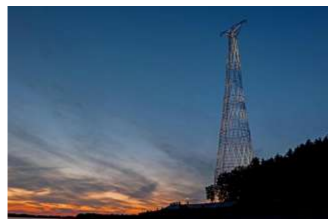
Изобр. 8. Опора ЛЭП НиГРЭС на Оке. Фото: ЗАО «СМУ-77», 2021 г. Интернет-источник: tehne.com
