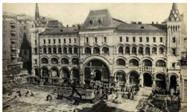
Изобр. 4. Передвижка доходного дома И. С. Кузнецова, ныне Саввинского подворья
