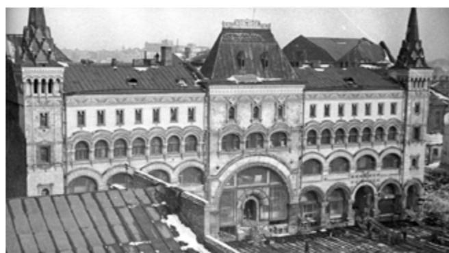
Изобр. 3. Передвижка доходного дома И. С. Кузнецова, ныне Саввинского подворья
