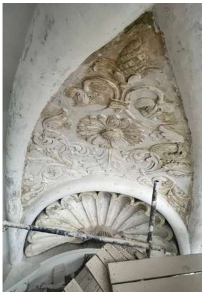
Изобр. 12. Реставрационные работы по лепному декору на главном фасаде
