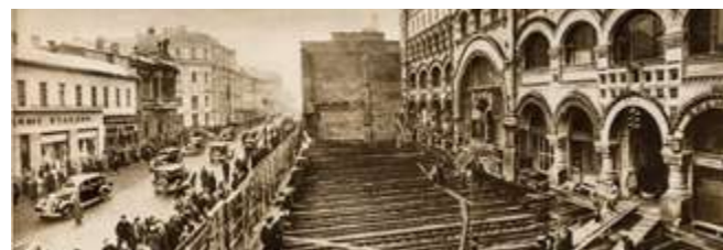
Изобр. 1. Передвижка доходного дома И. С. Кузнецова, ныне Саввинского подворья
