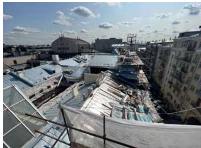
Изобр. 9. Ремонт кровли здания
