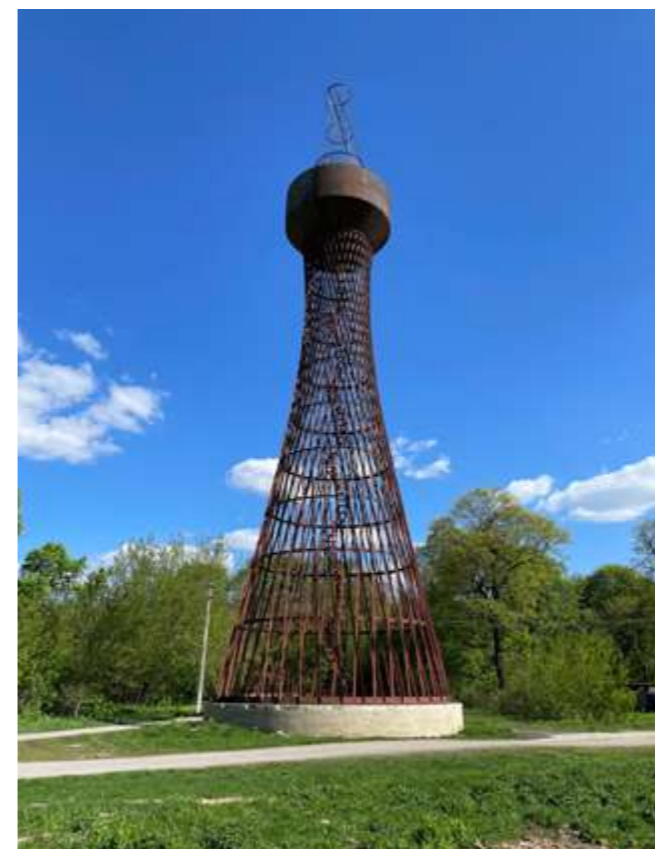
Изобр. 3. Водонапорная башня в усадьбе Нечаева-Мальцова, с. Полибино Липецкой области. Фото из открытых источников. Интернет-источник: yandex.com
