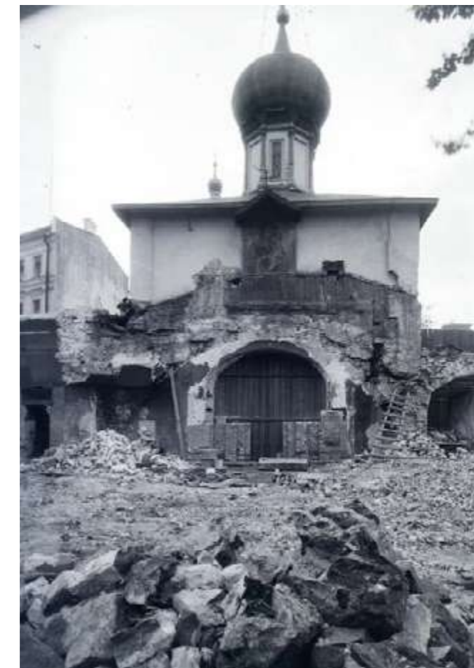
Изобр. 15. Вид на западный фасад храма после сноса трапезной и приделов в момент реставрационного воссоздания портала входа. Фото 1927 г.
