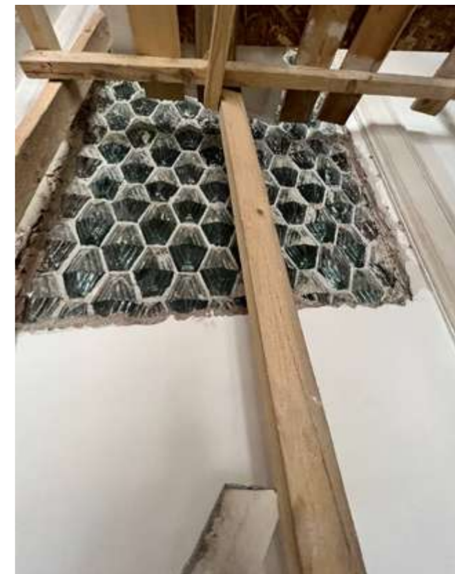
Изобр. 7. Воссоздание блоков Фальконе в исторических проемах подвезда
