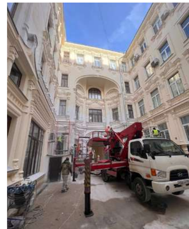
Изобр. 14. Реставрационные работы по лепному декору на фасадах
