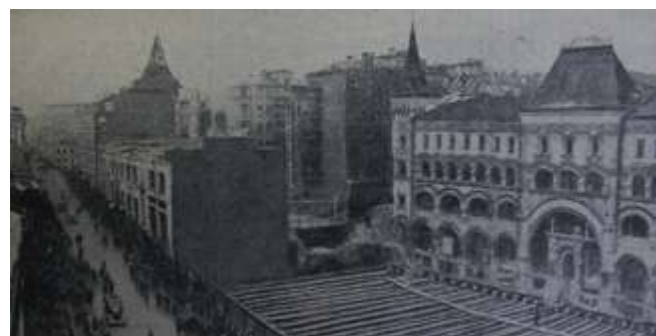
Изобр. 2. Передвижка доходного дома И. С. Кузнецова, ныне Саввинского подворья
